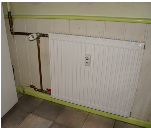
Attēls 3.3. Sildķermenis ar apvadcauruli, trīspļūsmu termostatisko vārstu un alokatoru
